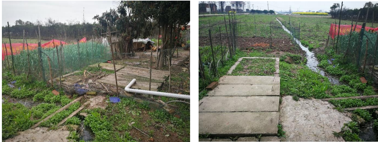
图 3.2-1 西湖管理区分散式污水处理设施现状照片
